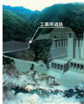
放水口工事用道路トンネル化
