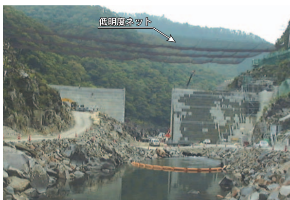
低明度ネット設置
