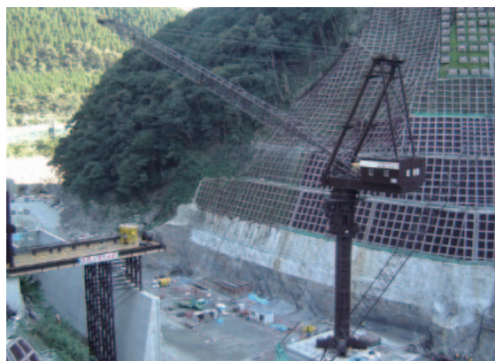
タワークレーンの低明度塗装
