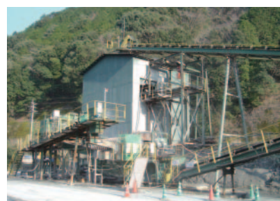
製砂設備の防音建屋
