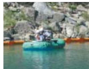
オイルフェンス設置及び油回収
