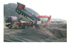
石炭灰を利用した工事の様子
