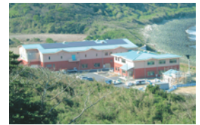
唐津北部衛生センター(太陽光発電助成先)
