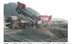
石炭灰を利用した工事の様子
