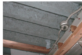
吹付け石綿 (建物への吹付け)
