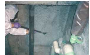
吹付け石綿の除去
