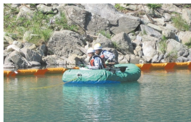
オイルフェンス設置及び油回収
