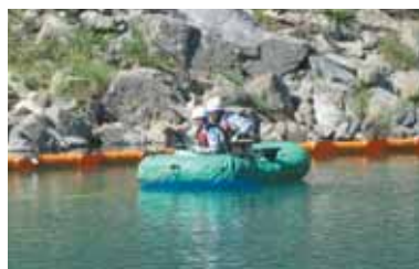
オイルフェンス設置及び油回収
