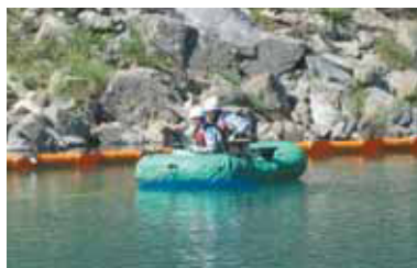
オイルフェンス設置及び油回収
