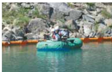
オイルフェンス設置及び油回収
