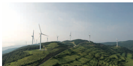
長島風力発電所(鹿児島県出水郡長島町)
