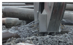
廃コンクリート柱を破砕
