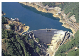
一ツ瀬ダム・貯水池(宮崎県西都市)
