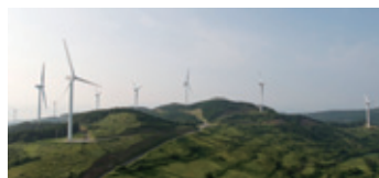
長島ウインドヒル(株)長島風力発電所
