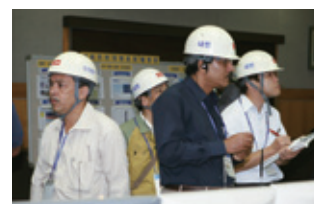
運転、性能管理状況などの確認 （ヨンフン火力発電所（仁川市））
