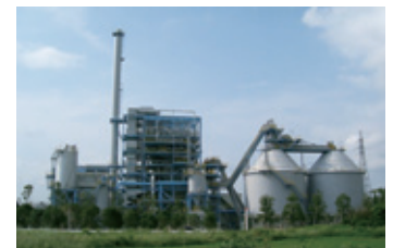
みやざきバイオマスリサイクル発電所
