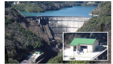
上椎葉ダムと上椎葉維持流量発電所
