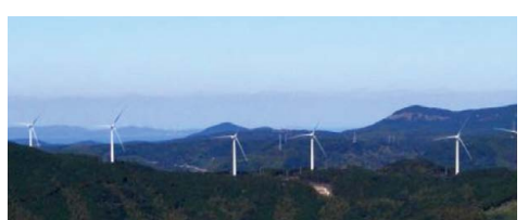
鷲尾岳風力発電所(グループ会社の鷲尾岳風力発電(株))
