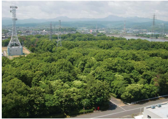
発電所構内緑地の様子(豊前発電所)
