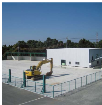
再生骨材製造プラント
