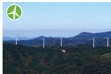
鷲尾岳風力発電所 (グループ会社の鷲尾岳風力発電(株))
