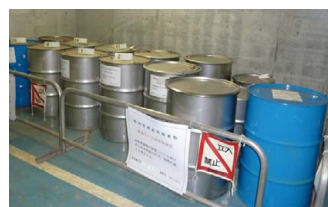
PCB廃棄物の保管・管理状況
