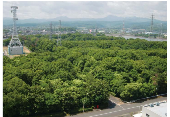
発電所構内緑地の様子（豊前発電所）
