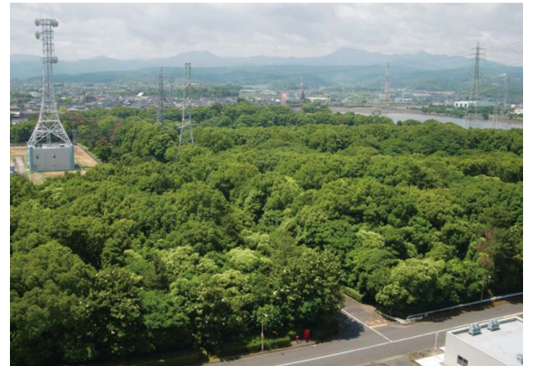
発電所構内緑地の様子（豊前発電所）
