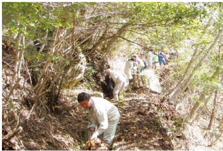
用水路浚渫作業の様子
