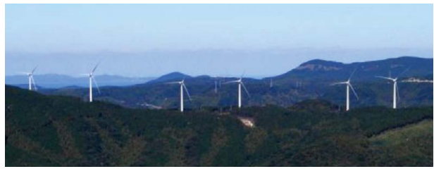
鷲尾岳風力発電所(グループ会社の鷲尾岳風力発電(株))
