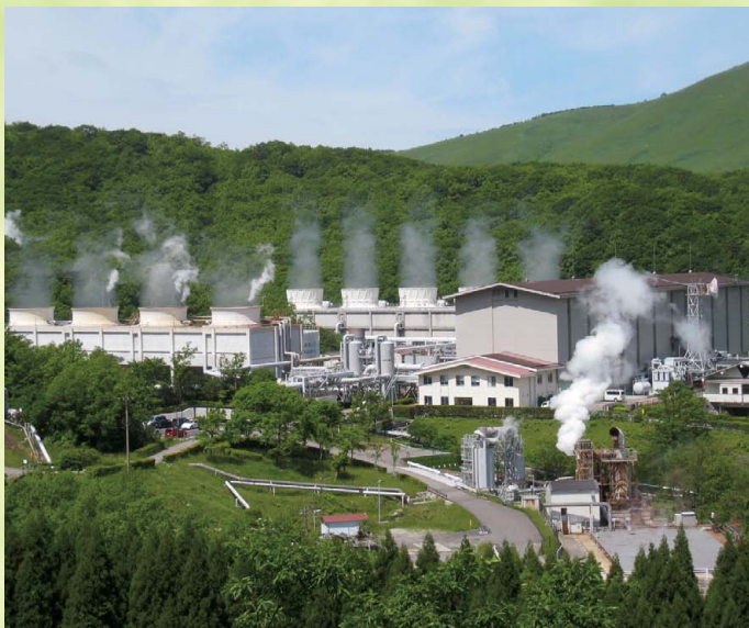
八丁原発電所(大分県九重町)
