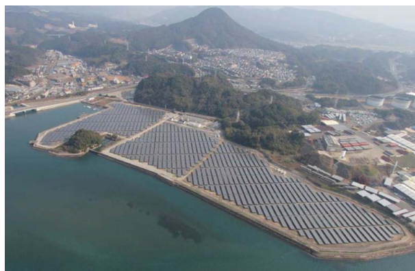
佐世保メガソーラー発電所(グループ会社の九電みらいエナジー(株))
