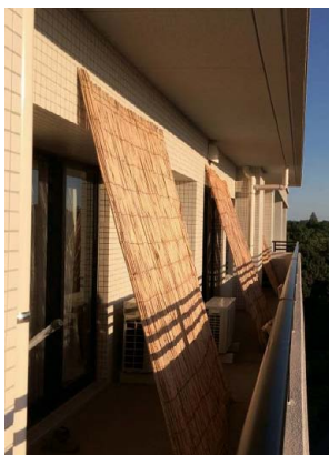
「よしず」による遮光対策(上) 自作のオーニング(日よけシート)による遮光対策(右)
