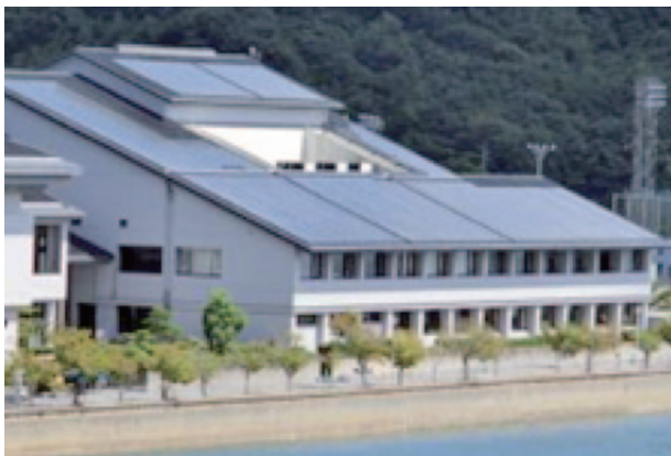
佐賀県玄海町の実証試験設備 <太陽光発電設備(屋根設置)>
