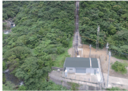
新名音川発電所
