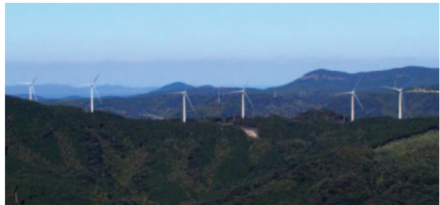
鷲尾岳風力発電所(グループ会社の鷲尾岳風力発電(株)) 風力発電については、風力発電の概要とあわせて、長島風力発電所(グループ会社の長島ウインドヒル(株))の発電状況をリアルタイムで公開。 詳細は九州電力ホームページ 関連・詳細情報(P2参照) > リアルタイムデータ(長島風力発電所)
