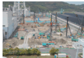
建設工事の様子
