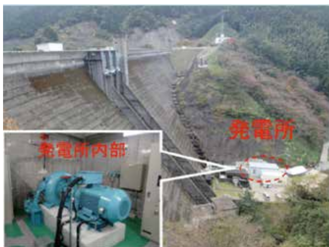
瑞梅寺ダム小水力発電所（福岡県糸島市）
