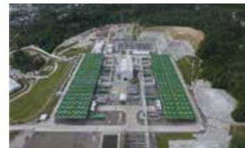
サルーラ地熱発電所初号機の全景
