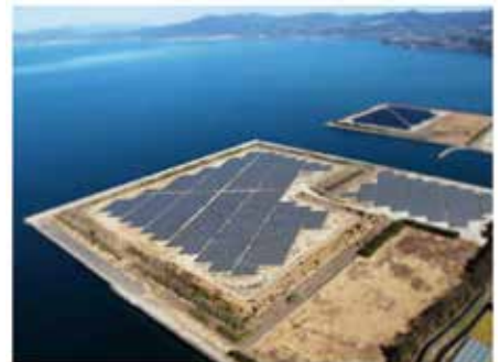
大村メガソーラー発電所
