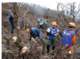
支障木の伐採
