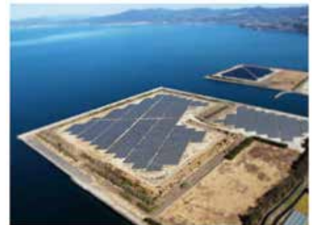
大村メガソーラー発電所
