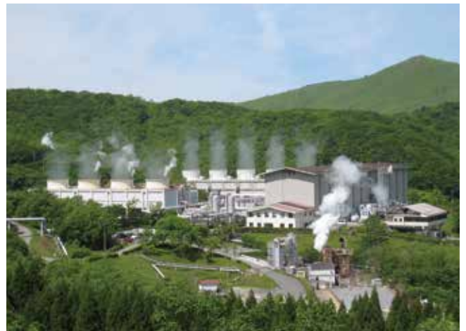
八丁原発電所
