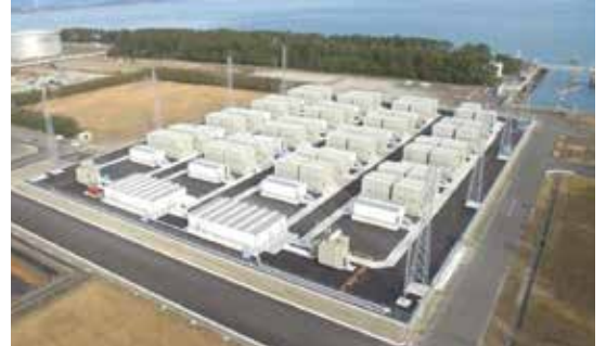
豊前蓄電池変電所の全景
