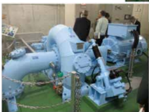
うきは藤波発電所
