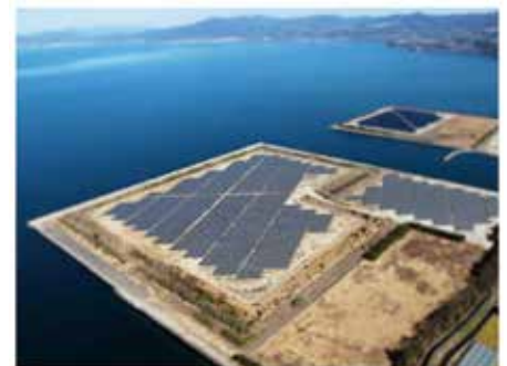
大村メガソーラー発電所
