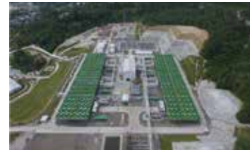
サルーラ地熱発電所初号機の全景
