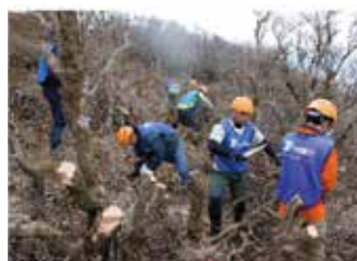
支障木の伐採
