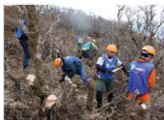
支障木の伐採
