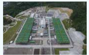
サルーラ地熱発電所初号機の全景
