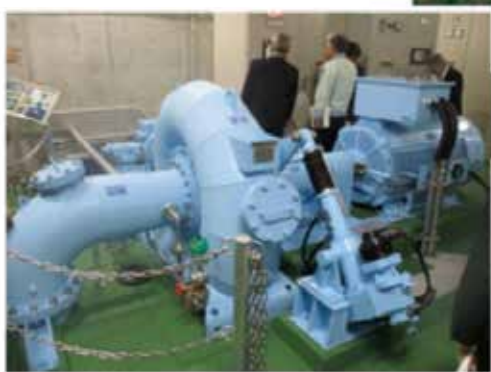
うきは藤波発電所
