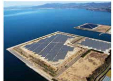
大村メガソーラー発電所
