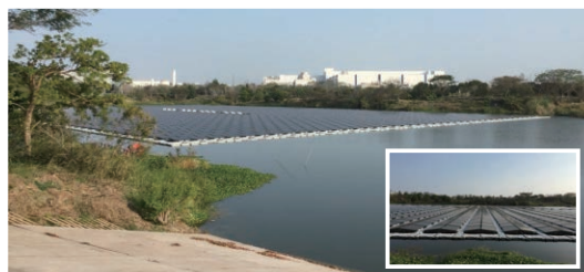
水上に浮かぶ樹谷(スグ)発電所
