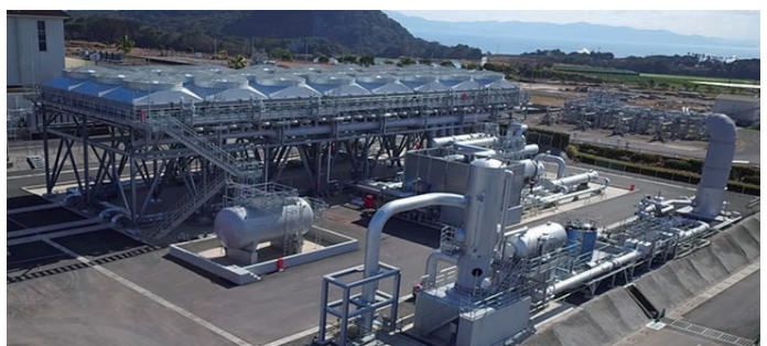
未利用エネルギーを活用した山川バイナリー発電所
