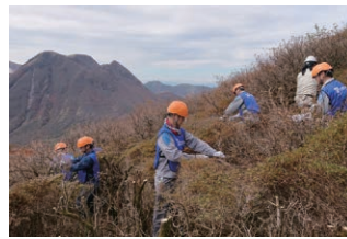
支障木の伐採
