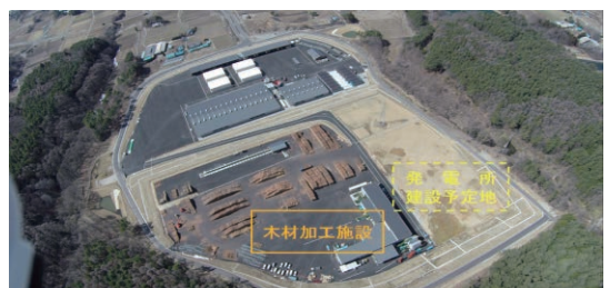
ソヤノウッドパーク敷地内の発電所建設予定地
