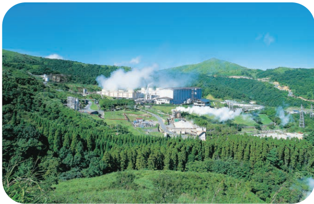
日本最大級の地熱発電所(八丁原発電所)
