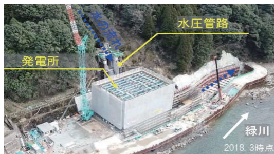
工事も大詰めを迎えている新甲佐発電所の開発状況
