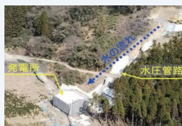
鴨猪水力発電所(2018年運転開始予定) [熊本県]
