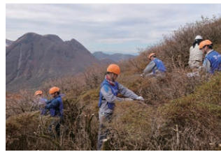
支障木の伐採
