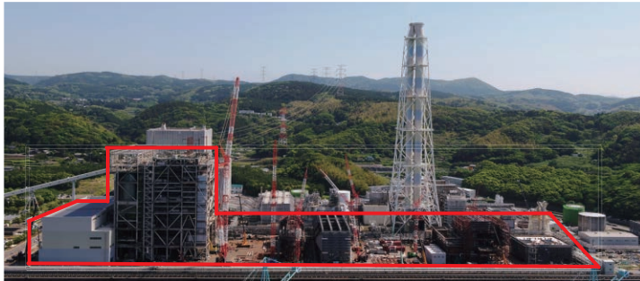
順調に工事が進んでいる2号機エリア全景写真(2018年5月10日撮影)
