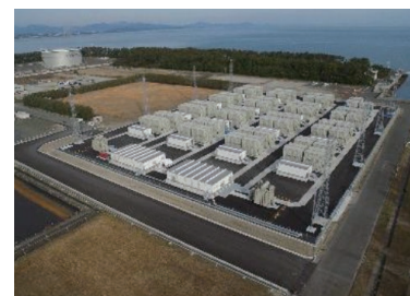
豊前蓄電池変電所
