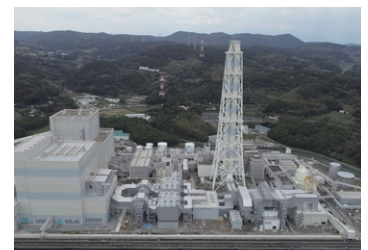
松浦発電所2号機2019年12月20日営業運転開始(手前側)
