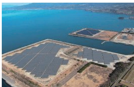
大村メガソーラー発電所
