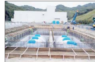
◇非常用ディーゼル発電機を連続7日間運転できるように燃料油貯蔵タンクを増設
