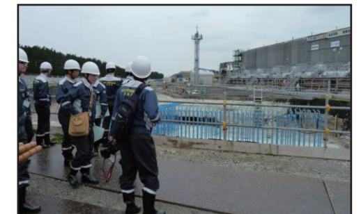
◇海水ポンプエリア津波対策工事状況の確認
