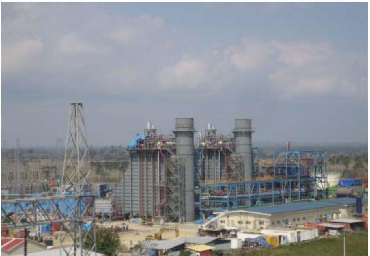
トックスパン 5号発電所 建設現場
