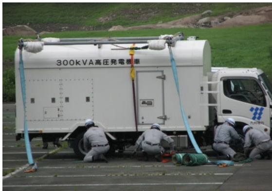
当社社員による懸吊工具の取り付け状況 ( 9月2日 総合防災訓練 )
