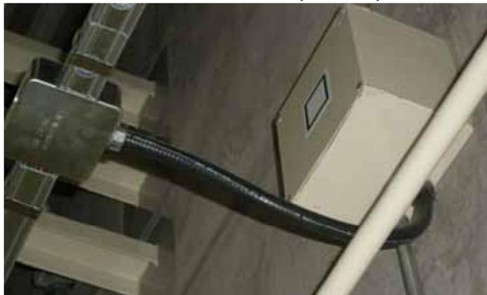
焼損した可とう電線管
