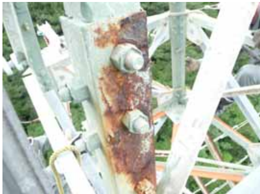
（鉄塔部材・ボルトの腐食状況）
