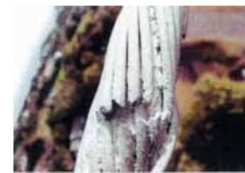
(腐食による電線素線切れ)
