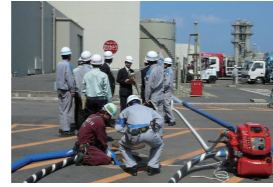
仮設ポンプ設置
