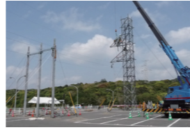
仮鉄柱組立・据付
