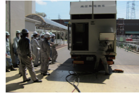
高圧発電機車の繋ぎ込み
