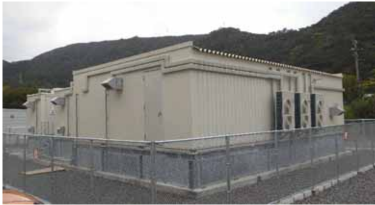
蓄電池収納建屋写真
