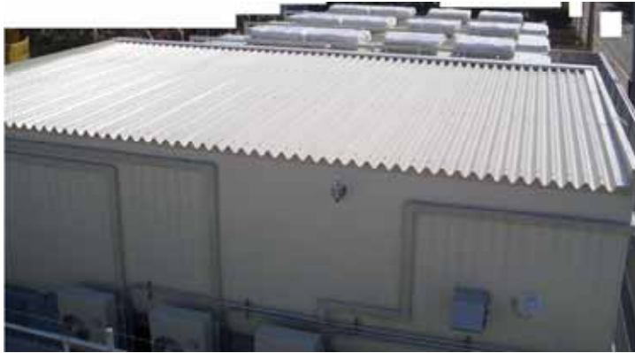
蓄電池収納建屋写真
