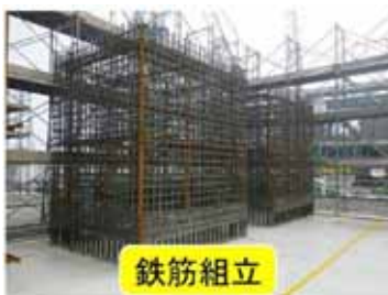
重量物を支持するための鉄筋コンクリート構造の架台
