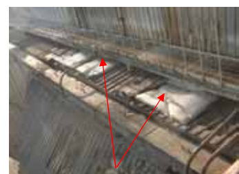
〔耐熱材による応急処置〕
