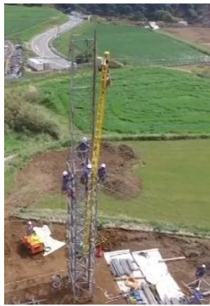
仮鉄柱構築作業
