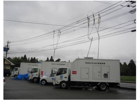
発電機車による送電
