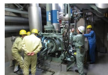
タービン動補助給水ポンプ作動試験
