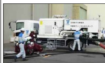
可搬型ディーゼル注入ポンプの設置
