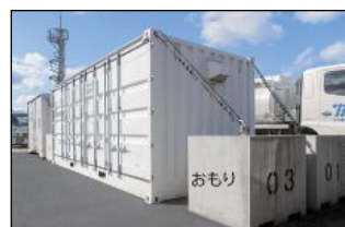
資材保管用コンテナの固縛 （竜巻対策）
