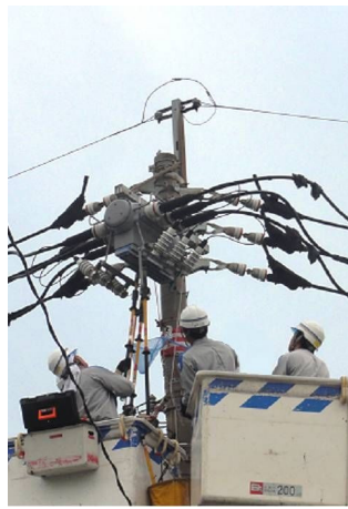
開閉器の現場修理
