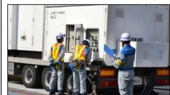
高圧発電機車による電源供給
