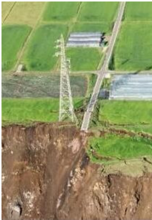
土砂崩れによる鉄塔被害
