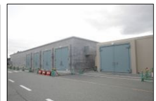
保管庫の設置 （竜巻対策）
