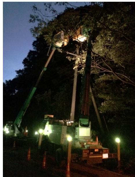
配電線被害の復旧作業
