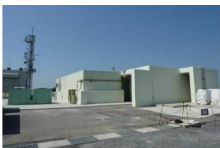
〔代替緊急時対策所〕
